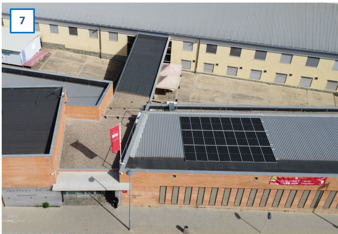
Imatge 7. Instal·lació fotovoltaica existent en modalitat autoconsum individual 10 kW amb compensació d'excedents
