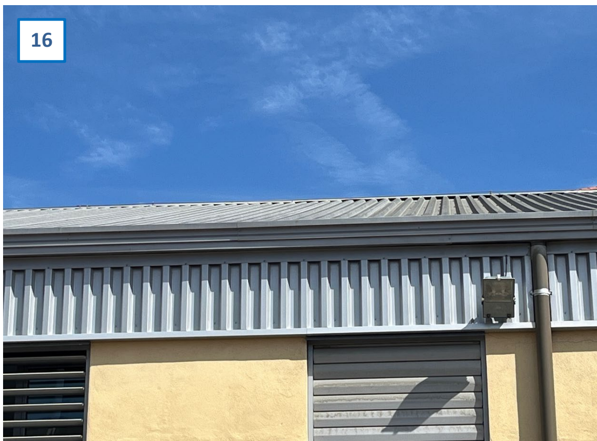
Imatge 16. Detall coberta xapa metàl·lica grecada
